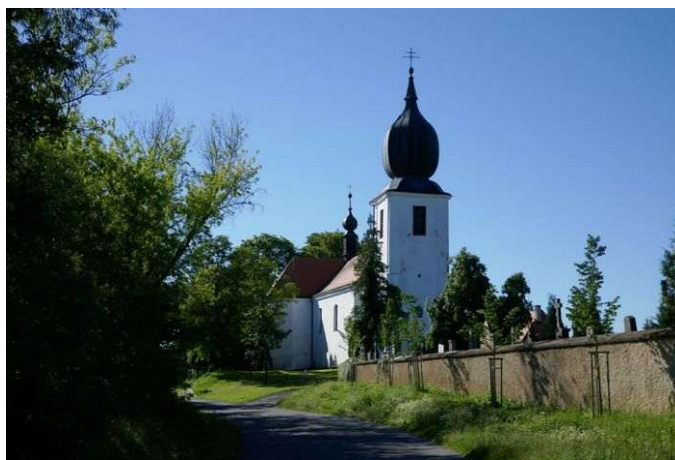
Starý Rožmitál – kostel Povýšení sv. Kříže
